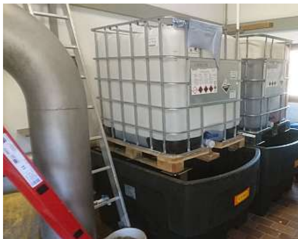
Abbildung 4.7: Fällmittel-Dosieranlage
