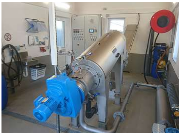
Abbildung 4.9: Schlamm entwässerung
