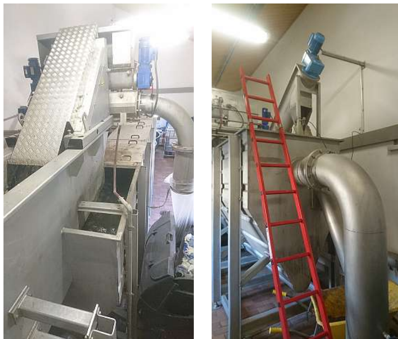
Abbildung 4.3: Rechen-Sandfang-Kompaktanlage
