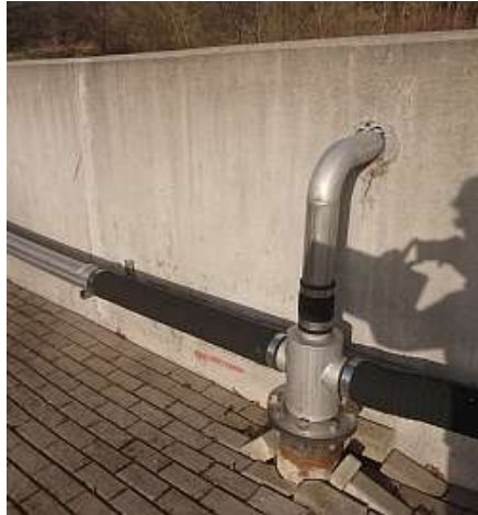
Abbildung 9.1: Luftverteilung Belebungsbecken
