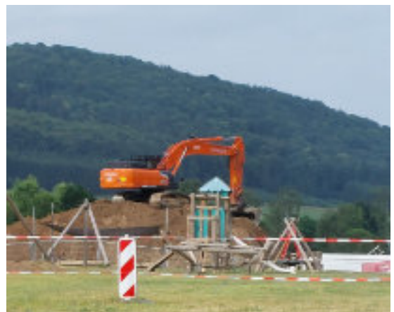
Beginn der Baustelle: Kinderkrippe Kirchahorn
